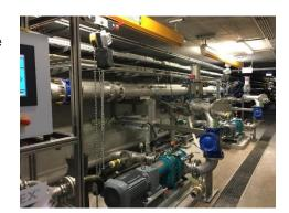
Der Kreativität der Verantwortlichen ist es zu verdanken, dass die Reinigung der Primär- und Schwimmschlammleitungen künftig durch den Einsatz des COMPREX®-Verfahrens deutlich effizienter gestaltet werden kann. Man entschied sich dafür, in eine eigene stationäre COMPREX®-Einheit zu investieren, um die Reinigungserfolge aufrecht zu erhalten.
